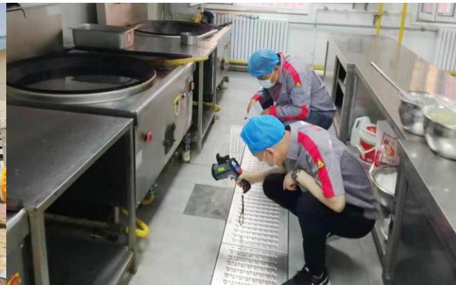
用户管道测漏
