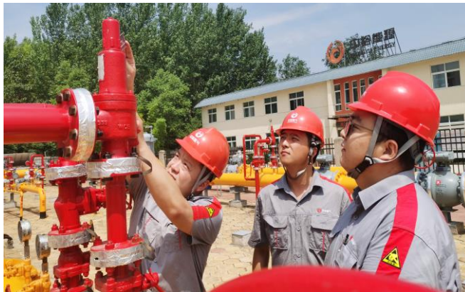
天然气门站检修
