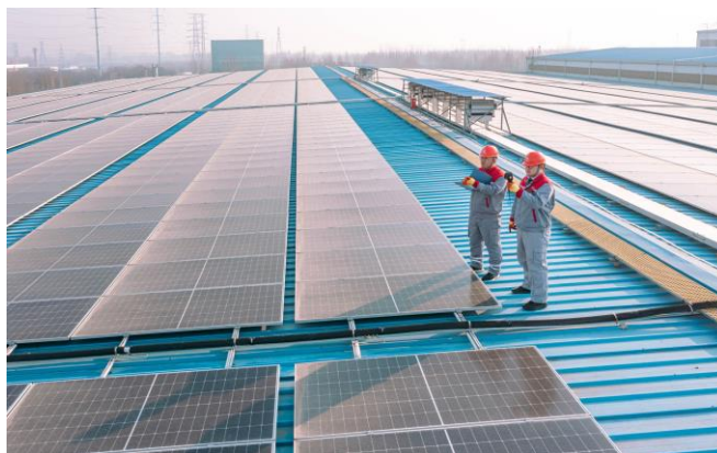
光伏电站巡检
